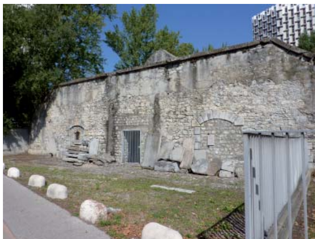
Transformation de la Poudrière réalisée par le Général HAXO en 1820
