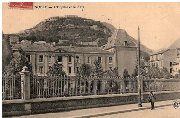
Hôpital de Grenoble réalisé au XVIII e siècle et démoli en 1935 pour réaliser la Banque de France boulevard Edouard Ret
