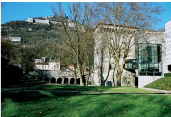
Intégration de la Tour de l'Isle et des fortifications dans le nouveau Musée de Peinture de Grenoble inauguré en 1991, construit à l'emplacement de la Caserne Vinoy
