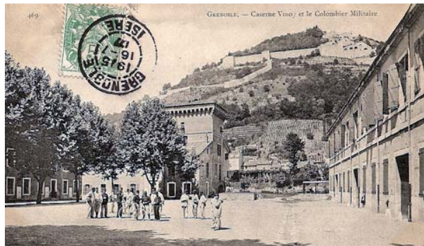
Tour de l'Isle et ancienne caserne Vinoy détruite en 1985 - 1990
