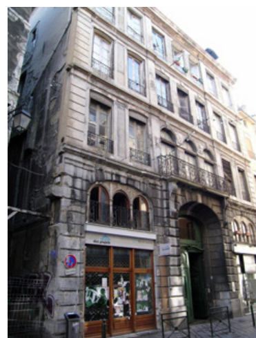
Façade rue Brocherie avant les travaux
