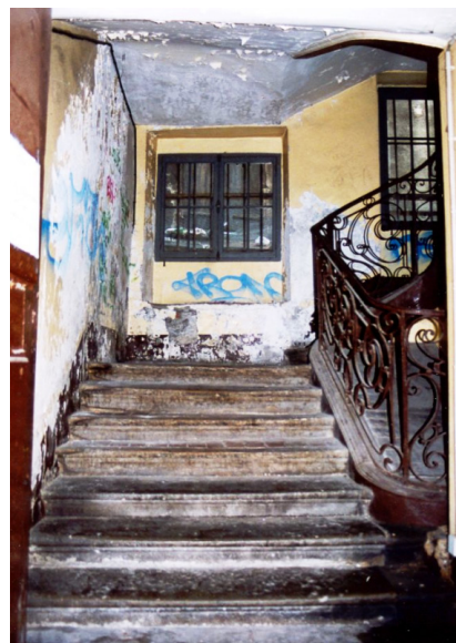
Escalier avant travaux
