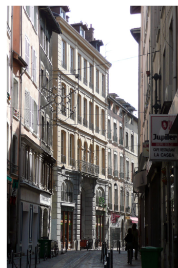
Façade rue Brocherie après les travaux
