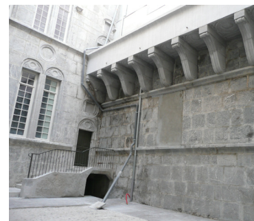
Cour intérieure consoles supportant la galerie de liaison
