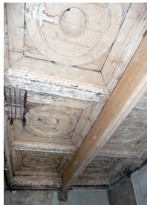
Plafond en bois état actuel
