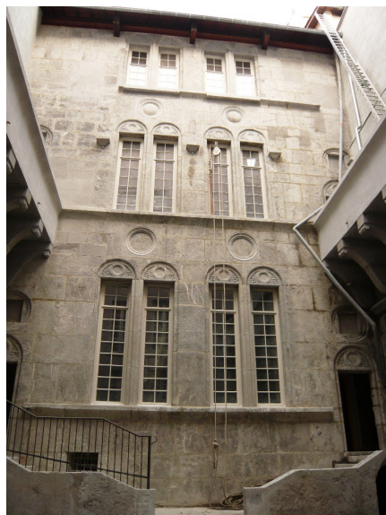
Cour intérieure après travaux
