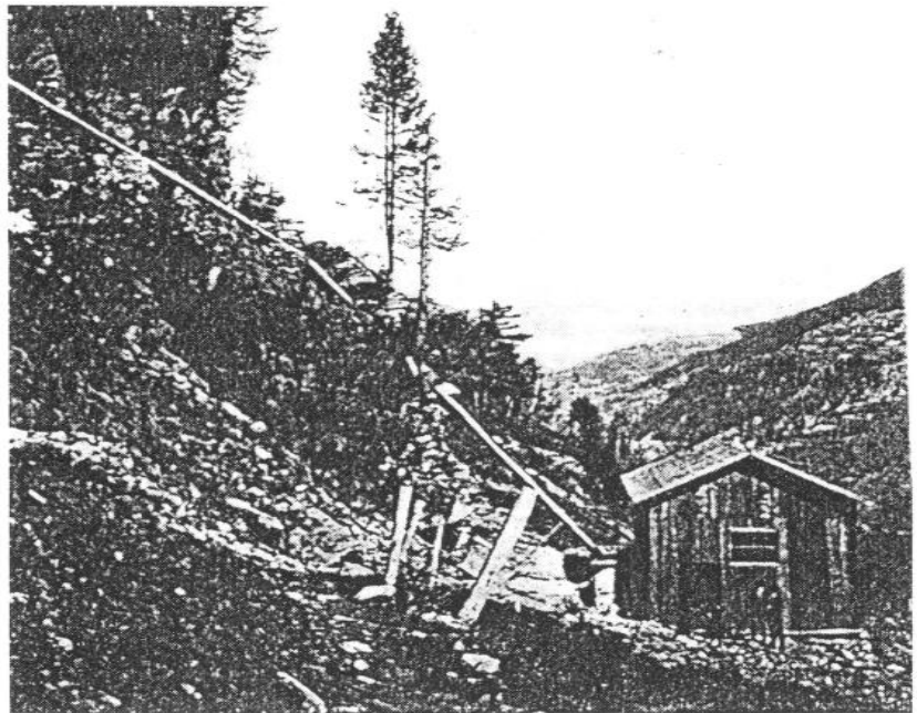
Société des Forces Motrices de la Haute-Isère. Conduite forcée en tubes électrolytiques. Hauteur : 100 m. Diamètre : 0,20 m. Epaisseur : 0,002 m.
