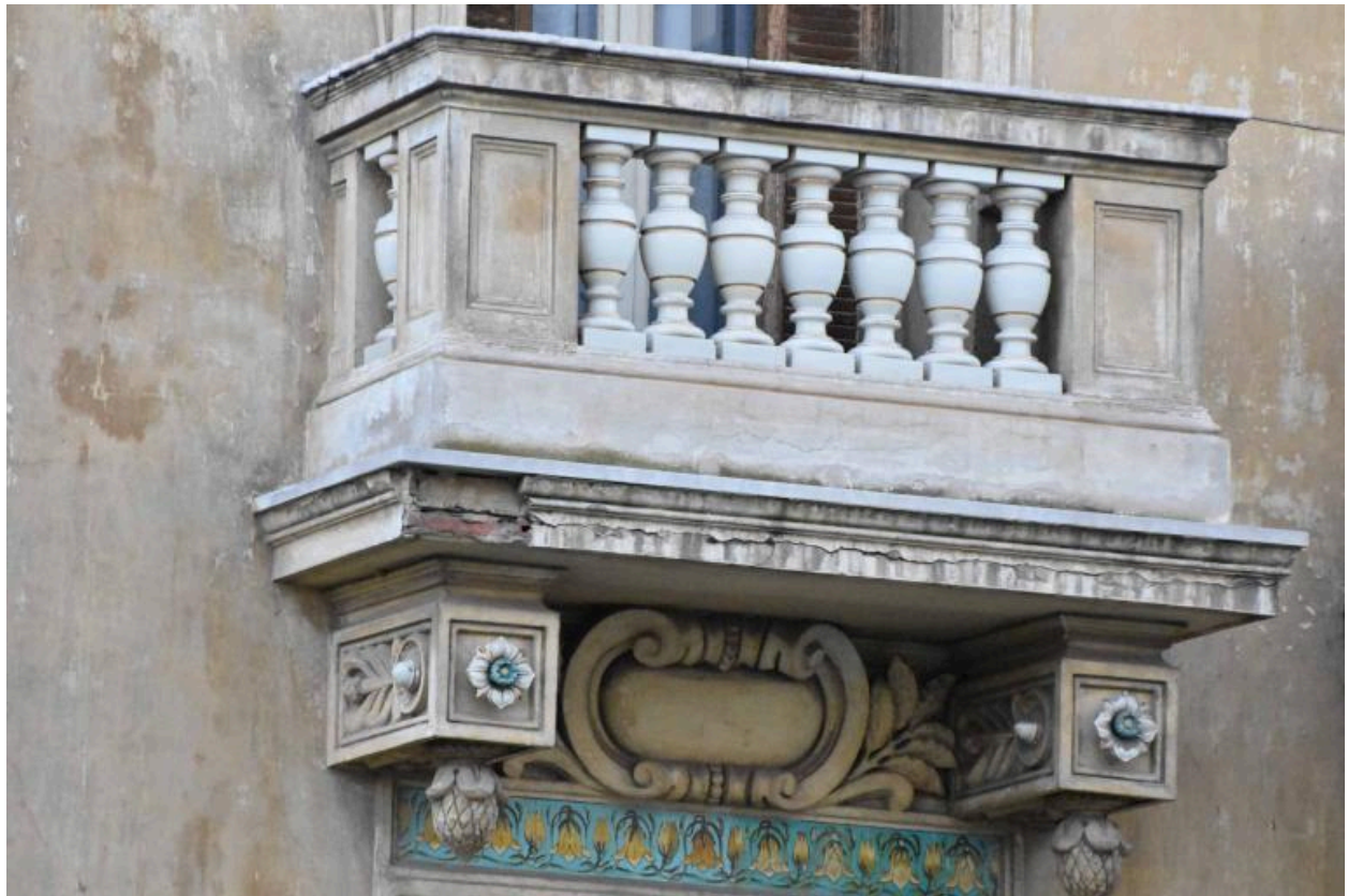
Détail du linteau des fenêtres du rez-de-chaussée et des balconnets du 1er étage.
