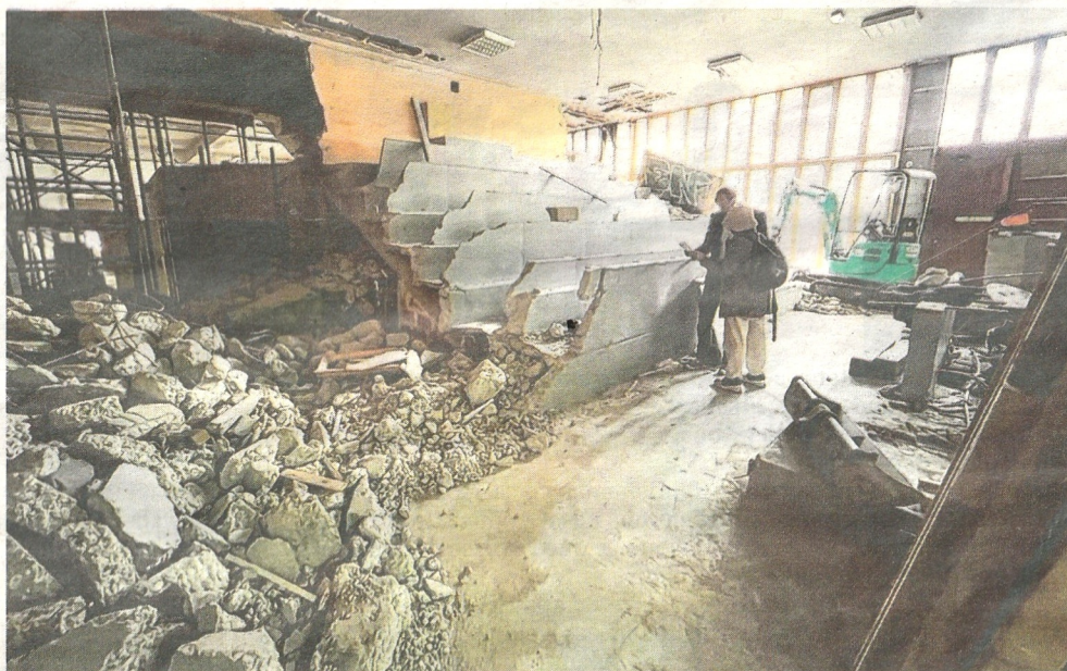
L'amphi en béton a été entièrement détruit et laissera place à un ouvrage plus confortable. Il sera accessible au public pour des conférences. Photos Le DL/Clément Berthet
